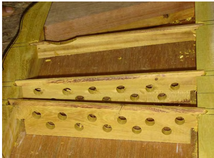
ภาพการเจาะสว่านไฟฟ้าเพื่อติดตั้งคานเสียง
