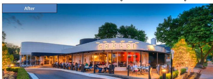
ภาพที่ 2- 6 Northville Garage
