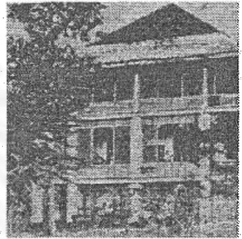
ภาพกงศุลอังกฤษ ริมน้ำเจ้าพระยา เป็นอาคารแบบ Colonial สูงสามชั้นมีเฉลียงโดยรอบ หลังคาปั้นหย่า สองช่วง มุงกระเบื้องดินเผาไม้เคลือบ ช่วงล่างมุงกระเบื้องแบบจีน มีเฉลียงโดยรอบอาคาร
