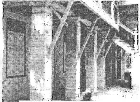
เสาอิฐหุ้มไม้ รับระเบียงไม้ ของอาคารโครงสร้างผนังรับน้ำหนัก
