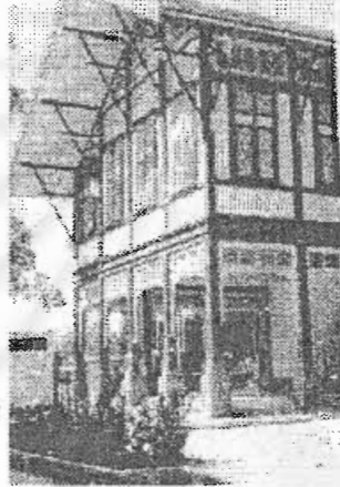
ภาพ กุฏิสงฆ์วัดราชาธิวาส สร้างโดยสมเด็จพระนางเจ้าเสาวภาผ่องศรี น.ณ.ปากน้ำกล่าวไว้เป็นแบบTudor ของอังกฤษ ที่มา:น.ณ ปากน้ำ, แบบแผนบ้านเรือนในสยาม,
