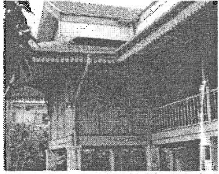
โครงสร้างเสาทำอิฐหุ้มไม้บ้านอับดุลราฮิม
