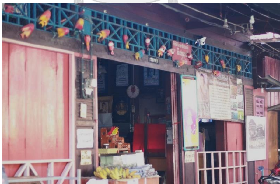
ภาพที่ 135 ลายฉลุช่องลมหรือช่องแสงและช่องเปิดประตูบานเฟี้ยมเดิม
