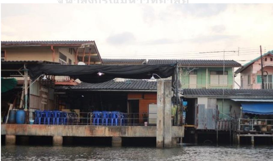
ภาพที่ 143 มุมมองจากแม่น้ำประแสที่เห็นตัวอาคารเรือนแถวและอาคารก่อสร้างใหม่
