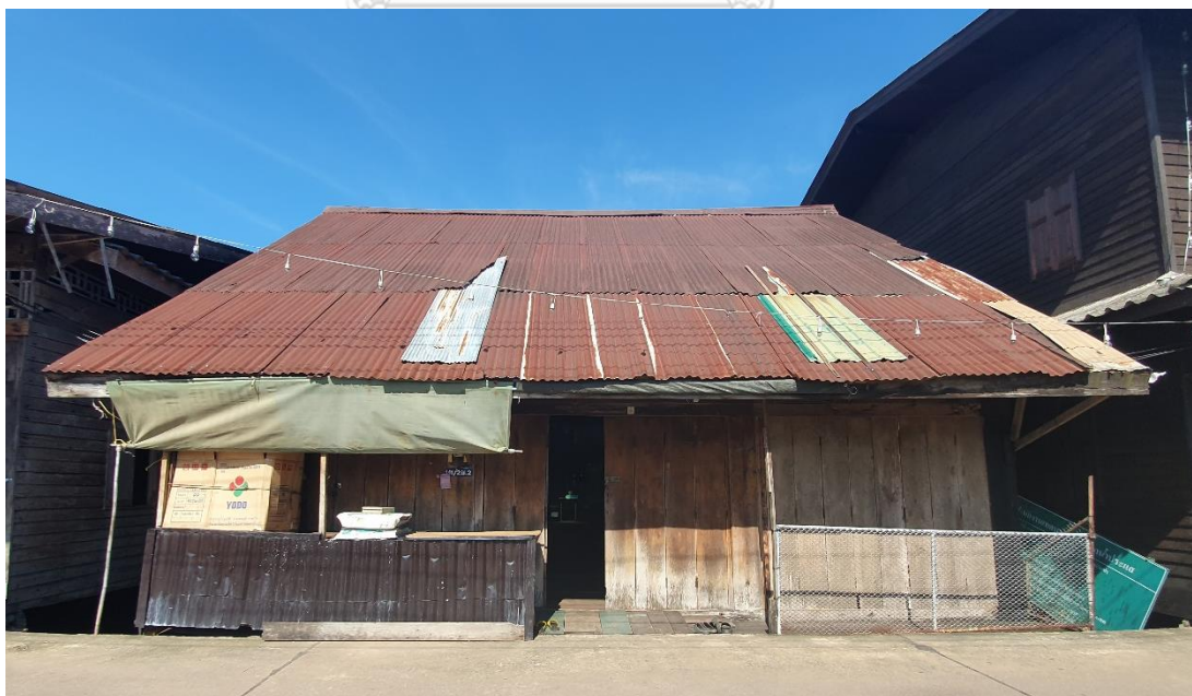
ภาพที่ 73 แสดงลักษณะช่องเปิดอาคารประตูบานเฟี้ยมดั้งเดิมและหลังคาทรงจั่วมุงสังกะสีลอนใหญ่เดิม
