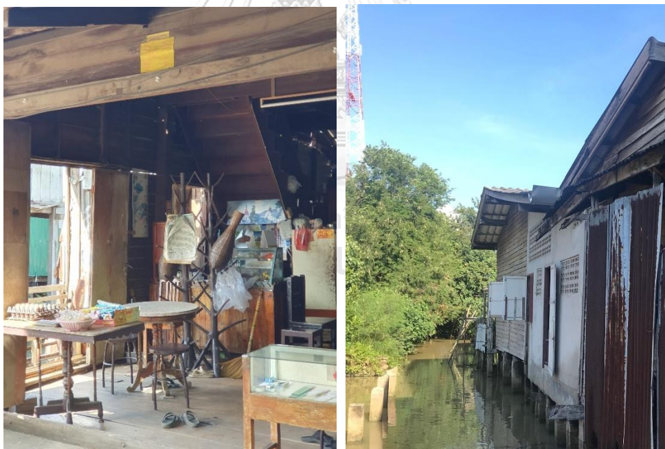
ภาพที่ 127 (ทางซ้าย) บรรยากาศที่นั่งทานกาแฟภายในเรือนแถว (ทางขวา) พื้นที่บริเวณโถงกลางที่เชื่อมต่อพื้นที่ใช้สอยทั้ง 2 กิจกรรมถูกต่อเติมเป็นผนังก่ออิฐ ที่มา : ผู้วิจัย, 2561
