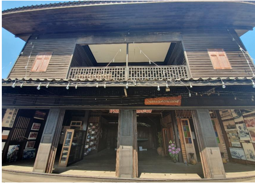
ภาพที่ 87 ลักษณะช่องเปิดอาคารประตูบานเพ็ญดั้งเดิม ที่มา : ผู้วิจัย 2562
