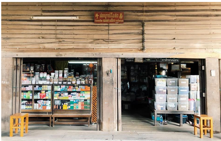
ภาพที่ 113 ลักษณะการตีไม้แนวอนปิดที่บผนังด้านหน้าอาคาร และช่องเปิดประตูบานเพี้ยมแบบดั้งเดิม ที่มา : นางสาวจิตสุภา ยอดบริบูรณ์, 2561
