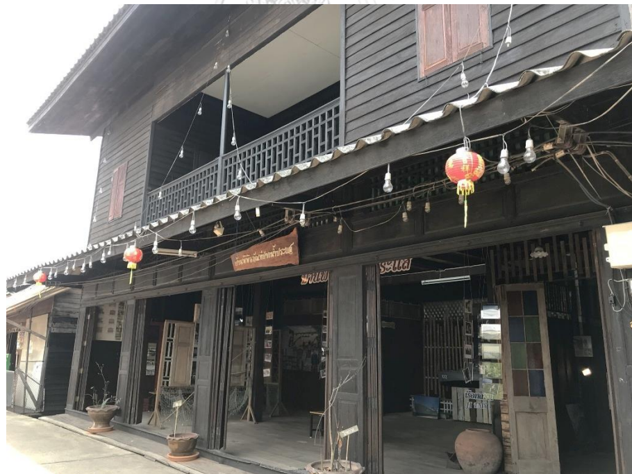
ภาพที่ 82 (ด้านบน) พื้นที่หน้าบ้านและพื้นที่หลังบ้านของเรือนแถวพิพิธภัณฑสถาน (ด้านล่าง) พื้นที่ได้ชಾಯคาและลักษณะชಾಯคาของเรือนแถวพิพิธภัณฑสถาน
