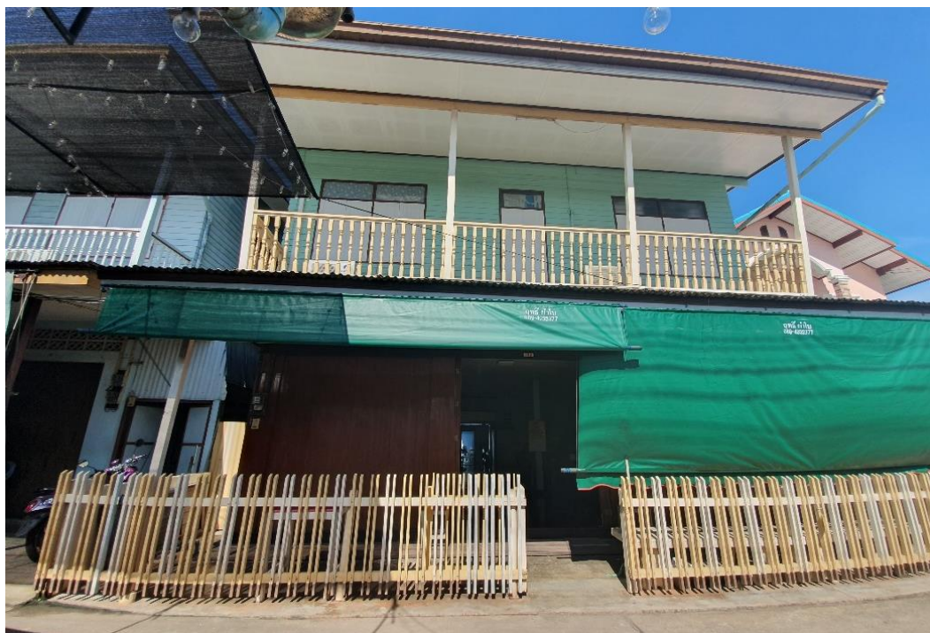
ภาพที่ 144 ลักษณะองค์ประกอบทางสถาปัตยกรรมของอาคารเรือนแถว
