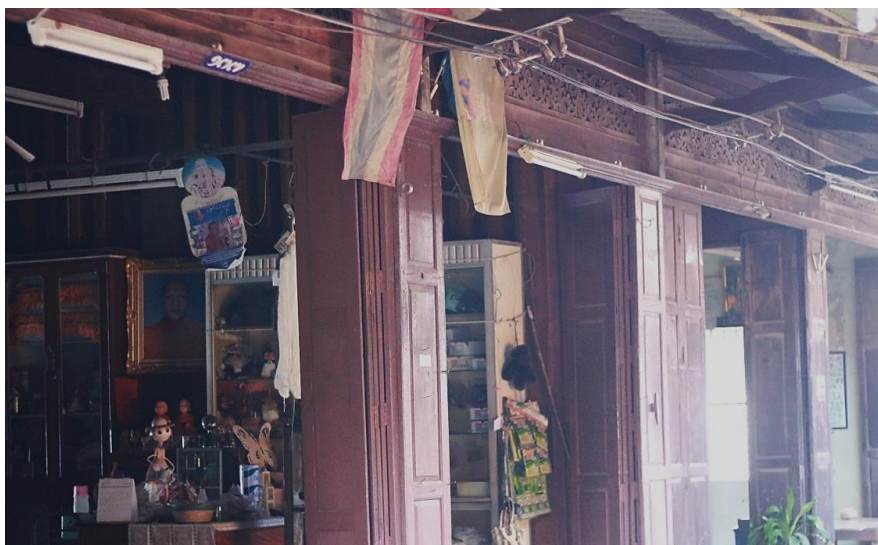
ภาพที่ 99 ลวดลายฉลุช่องลมเฉพาะยุคสมัย และลักษณะช่องเปิดประตูบานเพี้ยมดั้งเดิมประดับลายลูกฟัก ที่มา : ผู้วิจัย, 2561
