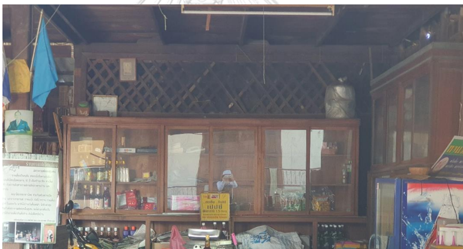
ภาพที่ 123 ช่องแสงหรือช่องลมภายในเรือนแถว
