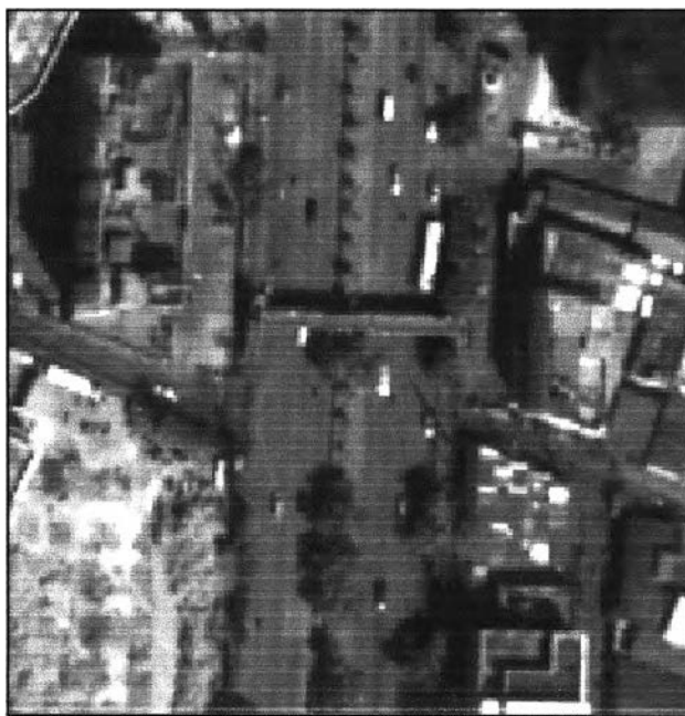
ซ) สะพานคนเดินข้ามถนน
