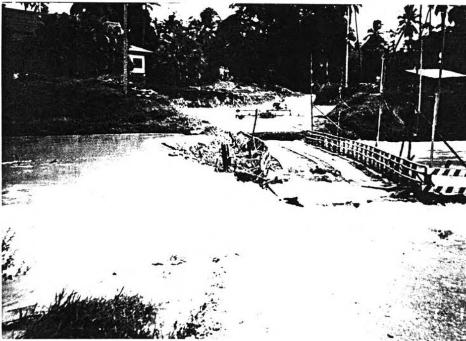
ภาพที่ 4.16 ผลกระทบจากอุทกภัยทำให้ถนนสะพานขาด
