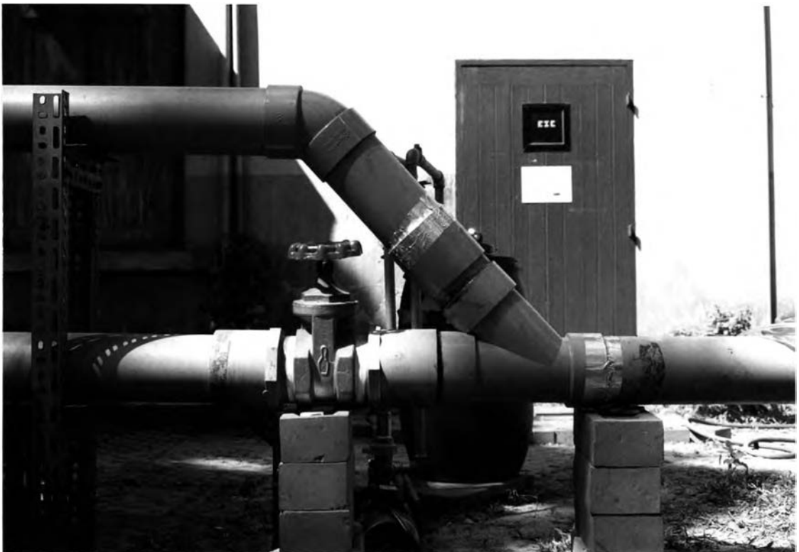
รูปที่ 5.4 แสดงท่อส่งอากาศ
