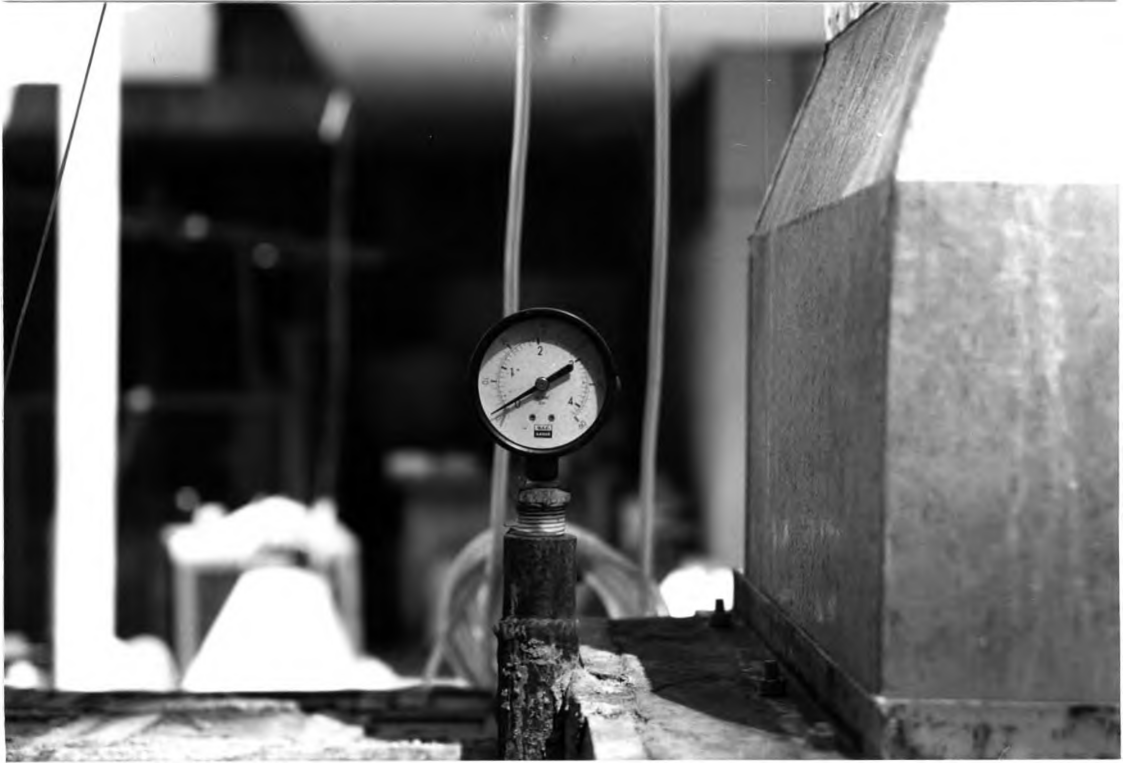
รูปที่ 5.13 แสดงเกจวัดความดันในหม้อไอน้ำ
