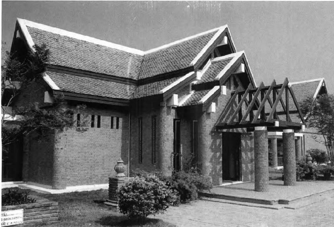
ภาพ 401 ผิวก่อสร้างหยาบด้าน (ผิวอิฐโชว์แนว)
