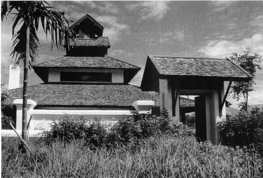
ภาพ 503 การใช้วัสดุตามแบบฉบับทางเหนือ (แป้นเกล็ด)
