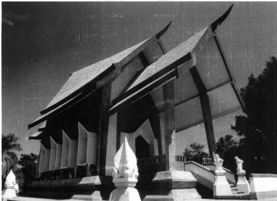
ภาพ 603 การใช้วัสดุซ้ำซ้อน (กระเบื้องดินเผาปูบนหลังคา ค.ส.ล.)
