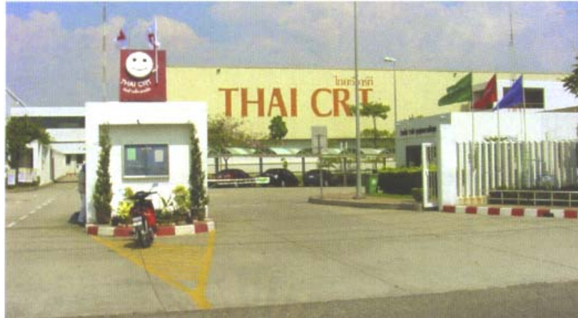
รูปที่ ข.5 โรงงานบริษัท ไทยซีอาร์ที จำกัด
