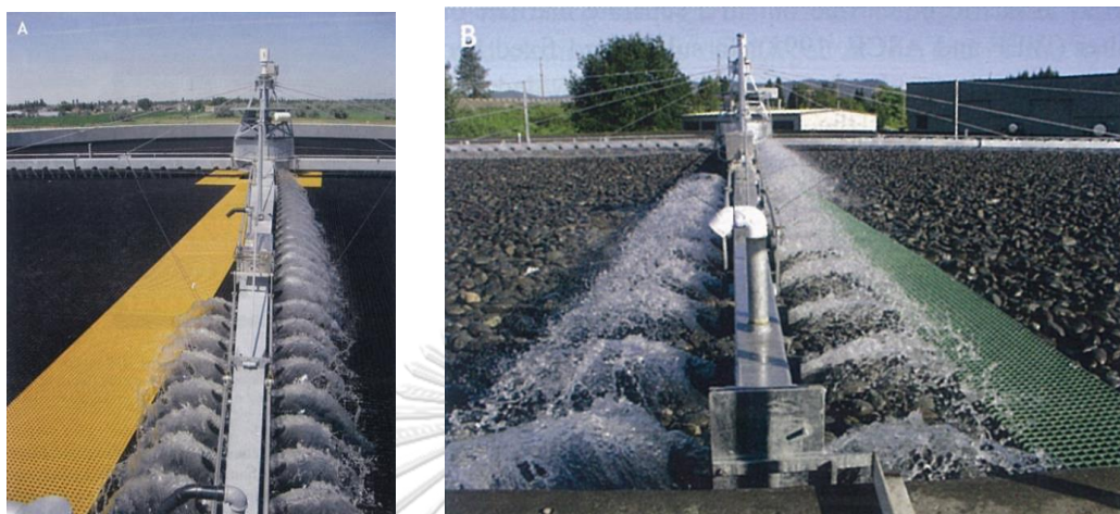
รูปที่ 2.1 ระบบบำบัดน้ำเสียแบบโปรยกรอง (ที่มา : Henze, Loosdrecht และคณะ, 2008)
