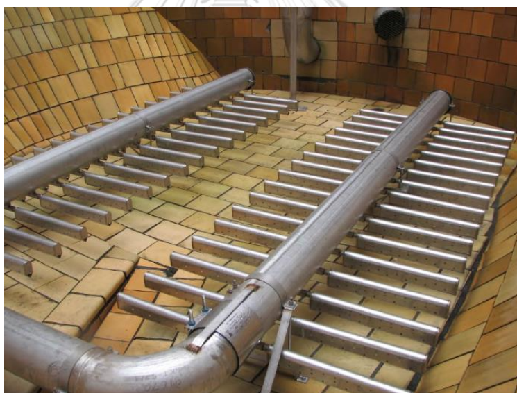
รูปที่ 2.13 ระบบเติมอากาศและกวนผสม
