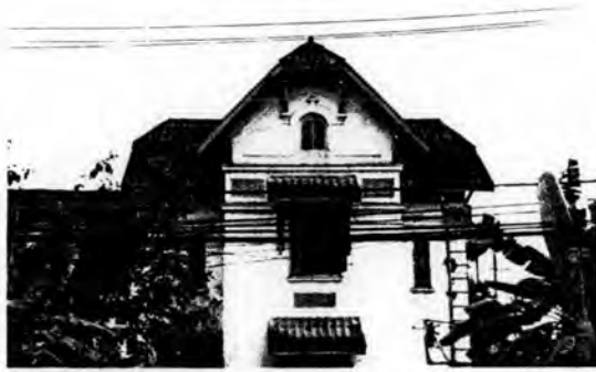
ภาพที่ 13 แสดงลักษณะโครงหลังคาและวัสดุผนังบ้านข้าราชการ (ต่อ)
