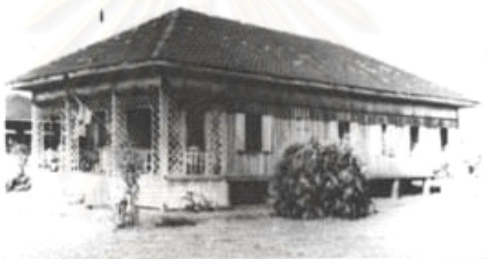
ภาพที่ 2-6 อาคารศาลจังหวัดตราด ไม่ทราบปีที่สร้าง (ปัจจุบันได้รื้อถอนไปแล้ว)
