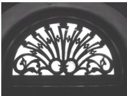
ภาพที่ 5-13 ลวดลายไม้ฉลุในซุ้มโค้งเหนือหน้าต่าง
