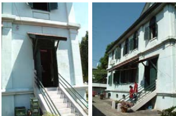
ภาพที่ 4-61 บ้านไต่ด้านหลังศาลมณฑลราชบุรี
