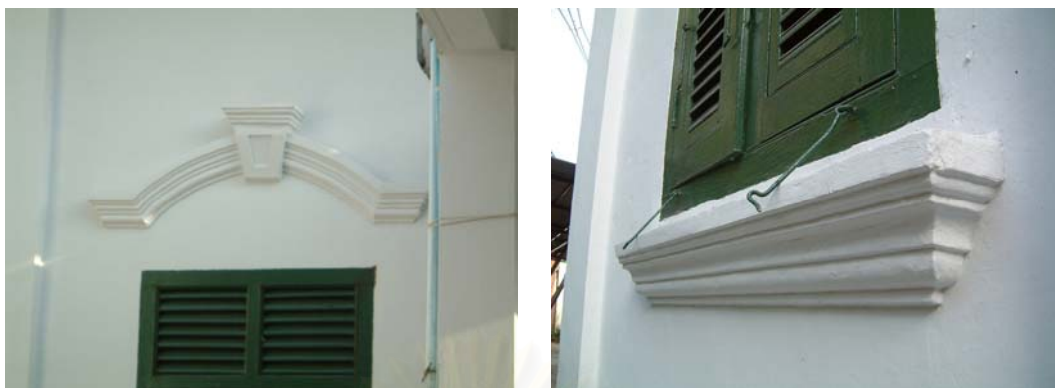
ภาพที่ 4-102 ส่วนตกแต่งผนังอาคารศาลมณฑลภูเก็ต
