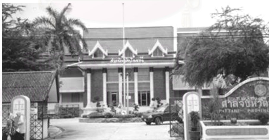
ภาพที่ 2-29 อาคารศาลจังหวัดปัตตานี สร้างเมื่อ พ.ศ.2505 เป็นอาคารตึก 2 ชั้น 4 บัลลังก์
