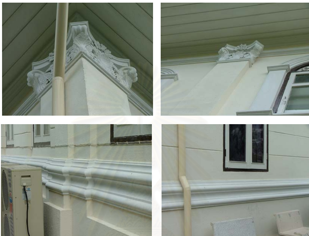
ภาพที่ 4-97 ส่วนตกแต่งผนังอาคารศาลมณฑลกรุงเก่า
