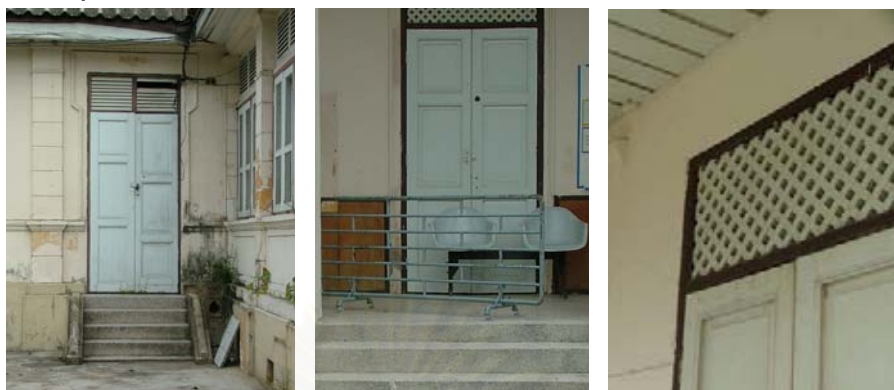
ภาพที่ 4-36 ประตูกว้างบานละ 50 เซนติเมตร วนรอบและกรอบบานไม้เนื้อแข็ง ลูกฟักไม้ กระจาดานดูน ด้านบนมีช่องแสงสี่เหลี่ยมภายในเป็นไม้ตีขัดกันเป็นแนวทแยง
