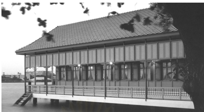
ภาพที่ 3-18 ตำนักริมน้ำ ธนาคารแห่งประเทศไทย ถนนสามเสน สร้างเมื่อ พ.ศ. 2457 ออกแบบโดย นายเอมิลิโอ โจวานนี กอลโล รูปแบบสถาปัตยกรรมโคโลเนียล มีหน้าต่าง และระเบียงโดยรอบ และมีแผงบังแดดเกล็ดไม้โปร่ง และไม้ฉลุตกแต่ง 46
