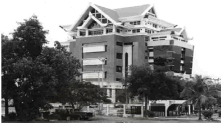
ภาพที่ 2-32 อาคารศาลแขวงชลบุรี สร้างเมื่อปี พ.ศ. 2541 เป็นอาคาร ค.ศ.ล. สูง 9 ชั้น
