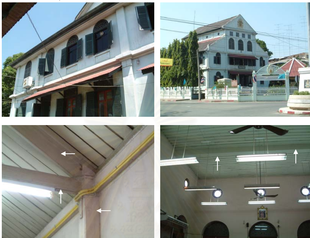
ภาพที่ 4-24 โครงสร้างและวัสดุผนังหลังคาอาคารศาลมณฑลราชบุรี
