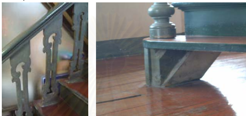
ภาพที่ 4-74 บันไดภายในด้านหน้าศาลมณฑลราชบุรี
