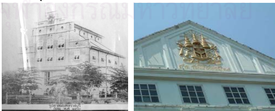
ภาพที่ 4-93 จั่วด้านหน้าอาคารศาลมณฑลราชบุรี
