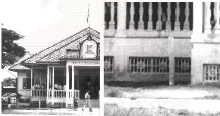
ภาพที่ 4-129 ช่องระบายอากาศอาคารศาลเมืองอ่างทอง
