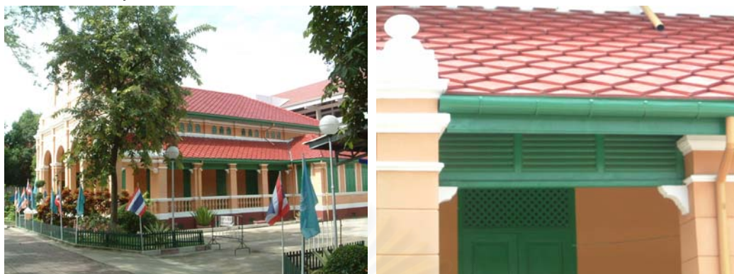
ภาพที่ 4-26 โครงสร้างและวัสดุผนังหลังคาอาคารศาลเมืองสิงห์บุรี
