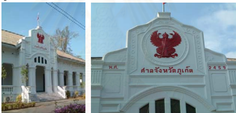
ภาพที่ 4-101 ส่วนตกแต่งหน้าจั่วอาคารศาลมณฑลภูเก็ต
