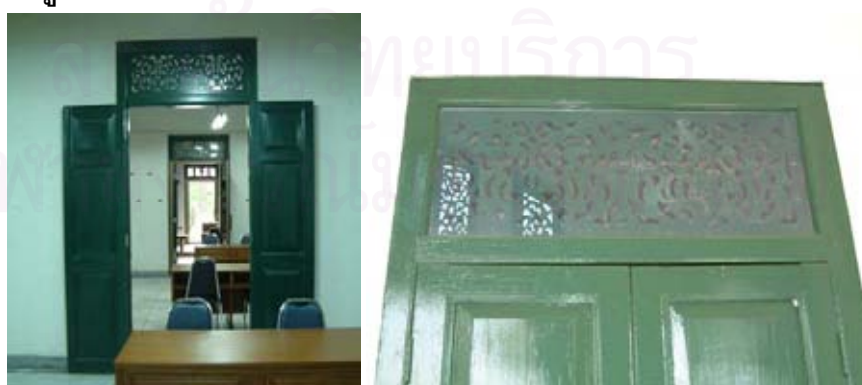
ภาพที่ 4-38 ประตูภายนอกและภายในศาลมณฑลภูเก็ต
