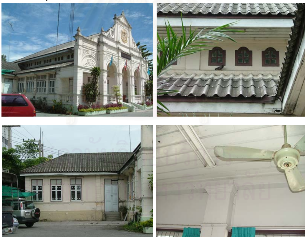
ภาพที่ 4-27 โครงสร้างและวัสดุผนังหลังคาอาคารศาลเมืองชลบุรี
