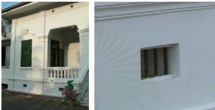
ภาพที่ 4-128 ช่องระบายอากาศอาคารศาลมณฑลภูเก็ต
