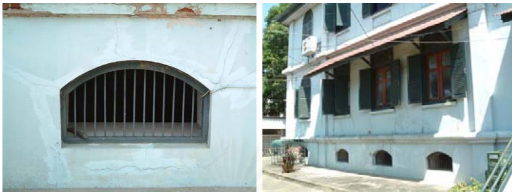
ภาพที่ 4-125 ช่องระบายอากาศอาคารศาลมณฑลราชบุรี
