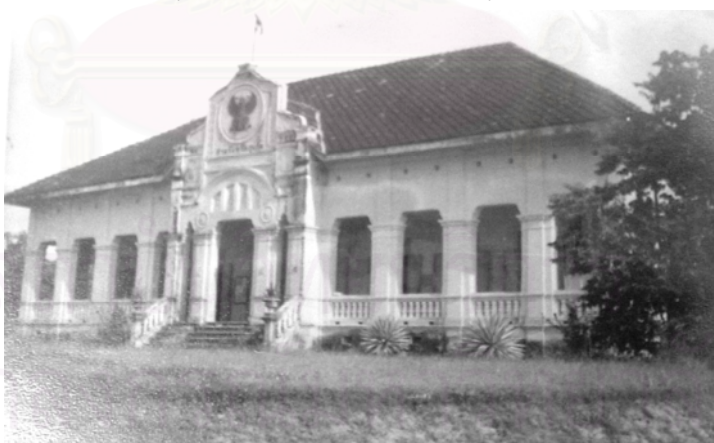
ภาพที่ 1-3 อาคารศาลมณฑลภูเก็ต สร้างเมื่อ พ.ศ.2459 (ปัจจุบันเป็นศาลแรงงานจังหวัดภูเก็ต) 5
