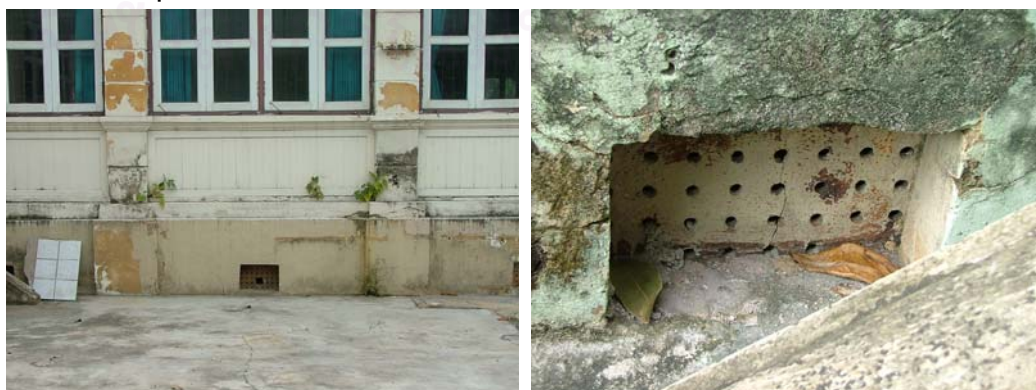
ภาพที่ 4-127 ช่องระบายอากาศอาคารศาลเมืองชลบุรี
