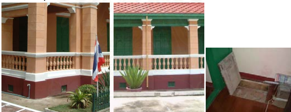
ภาพที่ 4-126 ช่องระบายอากาศอาคารศาลเมืองสิงห์บุรี
