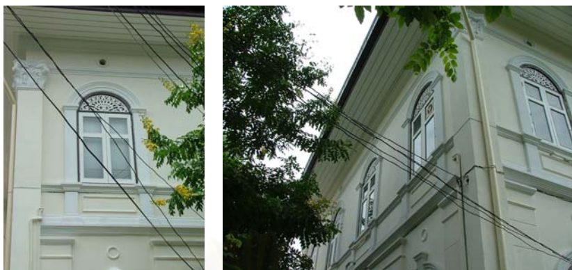
ภาพที่ 4-83 ผนังภายนอกอาคารศาลมณฑลกรุงเก่า
