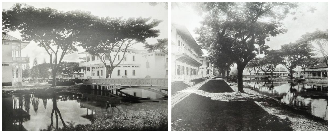
รูปที่ 3-63 สะพานพหลโยธิน มีตึกโขนยานนท์อยู่ทางขวา ตึกรัตนสังวาลอยู่ทางซ้าย
