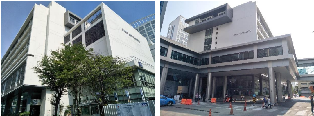
รูปที่ 3-88 (รูปซ้าย) อาคารอุปกรณ์เวชกิจ
