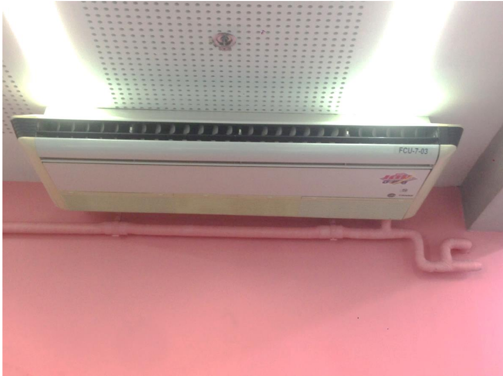
รูปที่ 1 เครื่องปรับอากาศแบบแยกส่วน คอยล์เย็น ห้องเรียน 709
