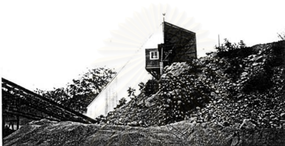
รูปที่ 4.11 อาคารที่สร้างปิดครอบปากโม้ใหญ่ โรงม่ขุมเงินขุมทอง มีช่องเปิดใหญ่ สำหรับเทหินจากรถบรรทุก
