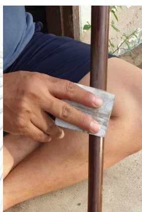
ภาพที่ 3.118 การขัดกระดาษทรายก่อนการทำสี
