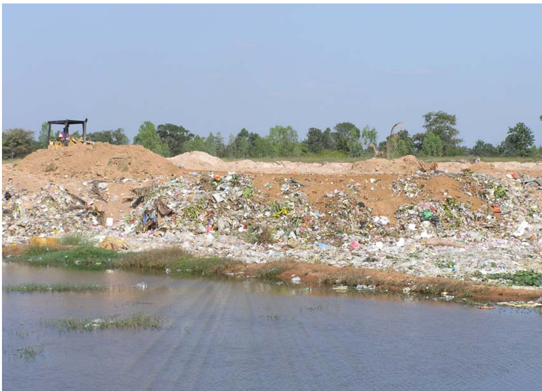
รูปที่ ง.21 แสดงสภาพเมื่อทำการฝังกลบเสร็จสิ้นในแต่ละวันของทม.เมืองพล
