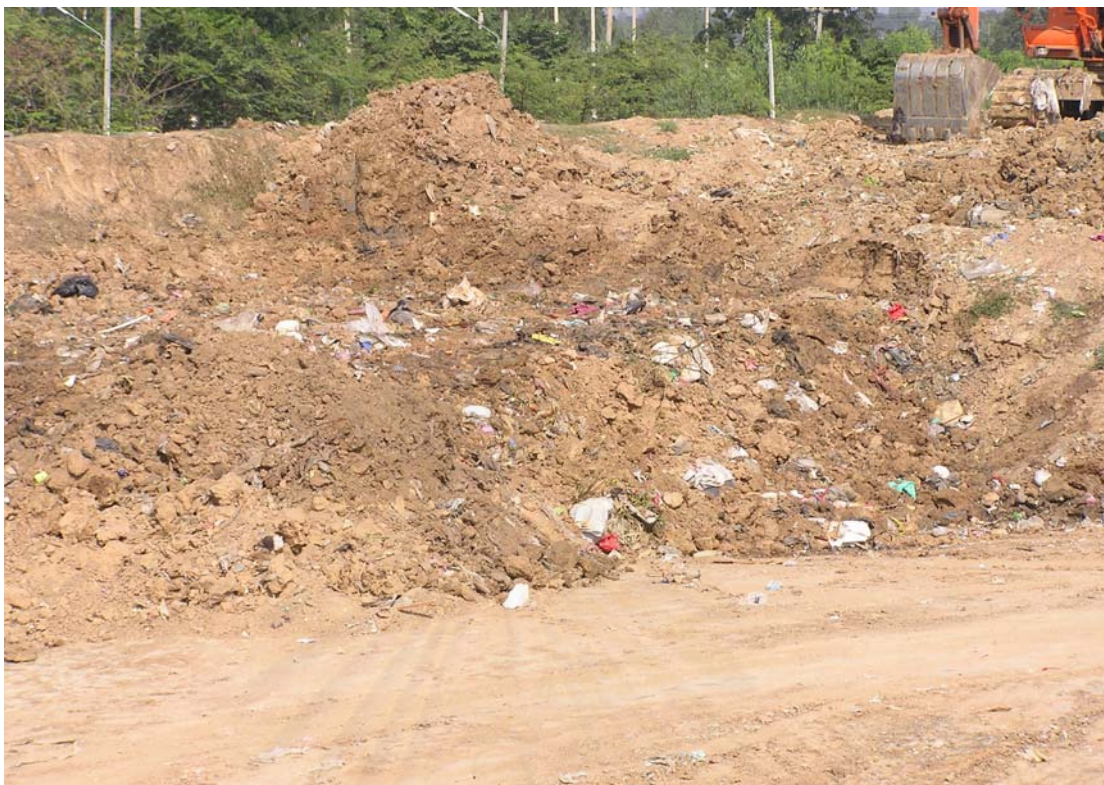
รูปที่ ง.59 สภาพพื้นที่ฝังกลบภายหลังทำการเคลียดินในแต่ละวันของทม.สุรินทร์
