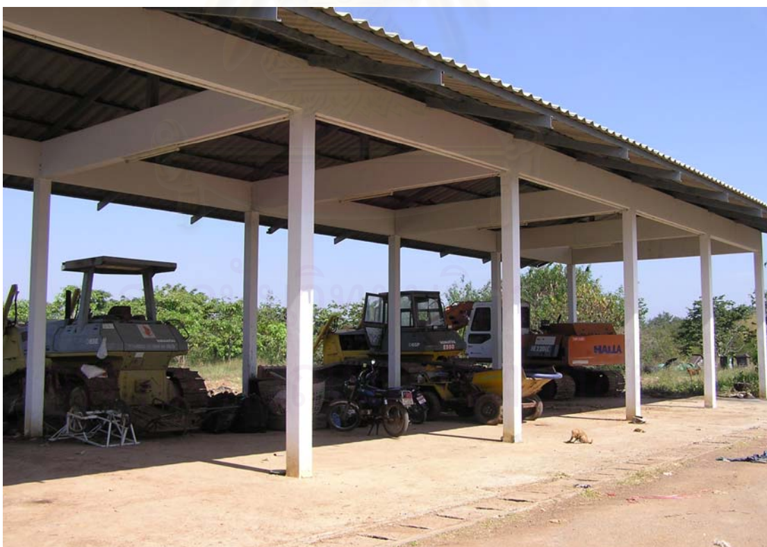
รูปที่ ง.16 สภาพของอาคารจอดเครื่องจักรของทม.เพชรบูรณ์
