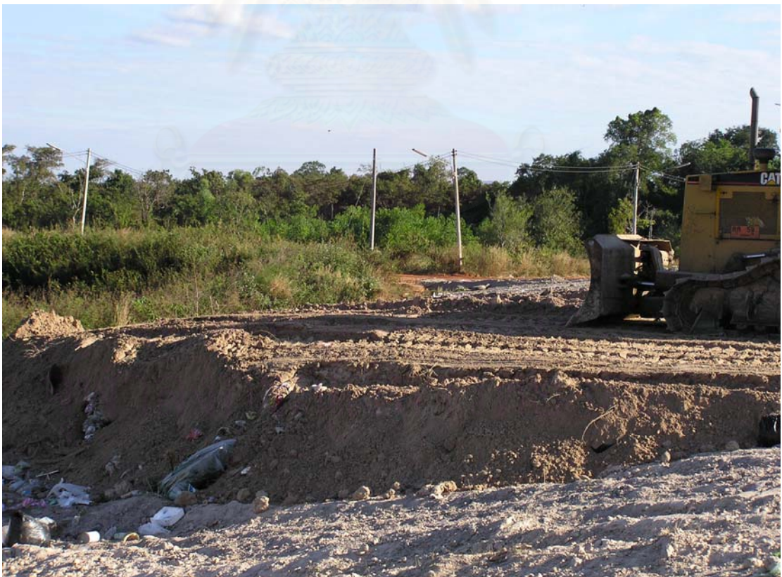
รูปที่ ง.50 สภาพพื้นที่ฝังกลบภายหลังการปิดหน้าดินเสร็จสิ้นในแต่ละวันของทม.สกลนคร
