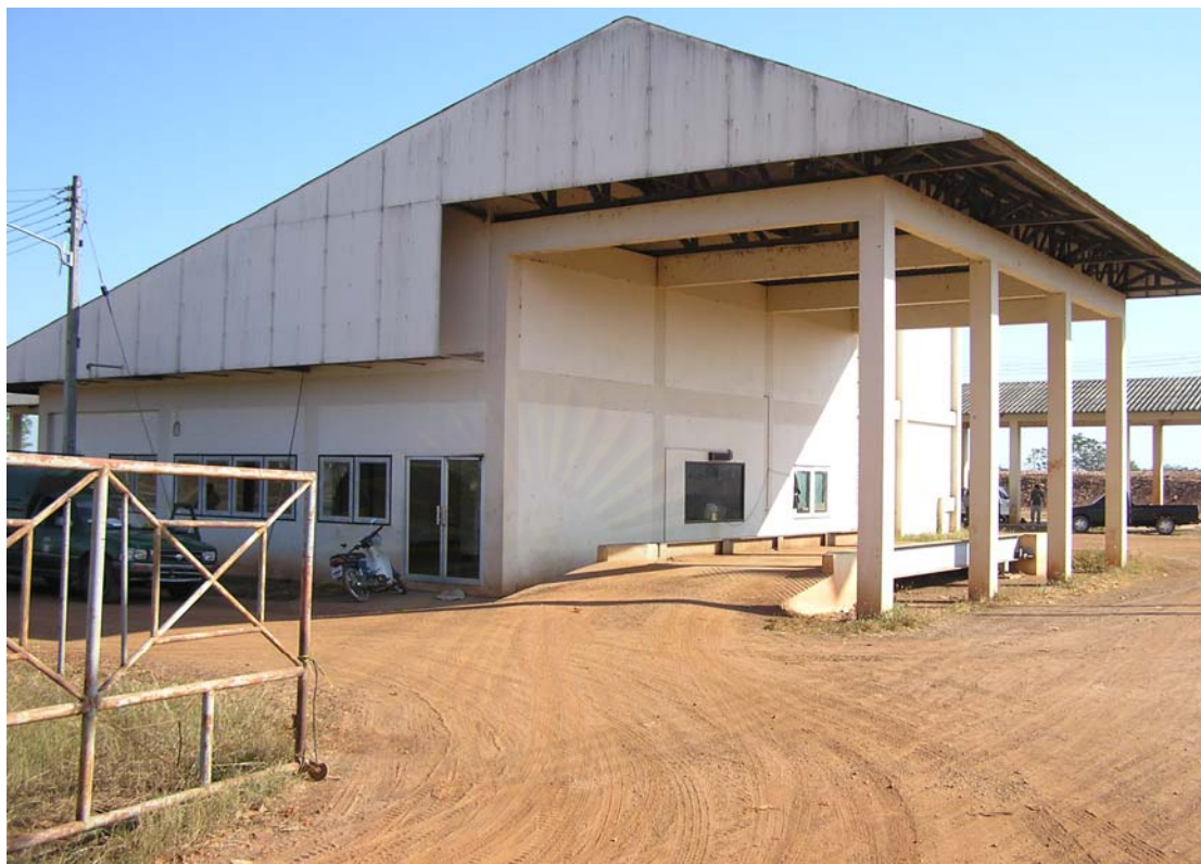
รูปที่ ง.28 สภาพของอาคารชั่งน้ำหนักขยะมูลฝอยของทม.นครพนม
