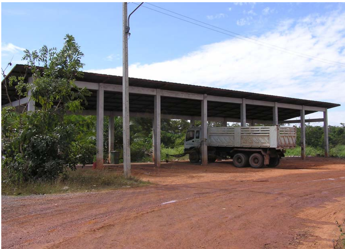
รูปที่ ง.53 สภาพอาคารจอดเครื่องจักรของทม.สกลนคร
