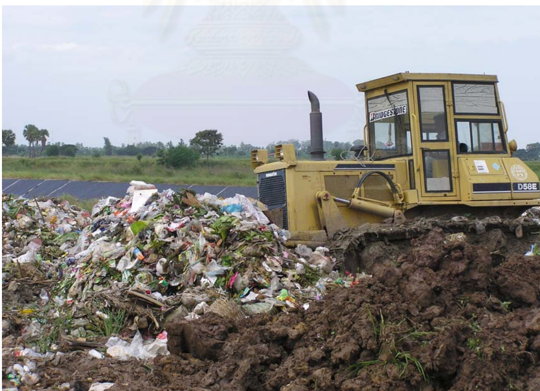
รูปที่ ง.64 การบดอัดขยะมูลฝอยของทม.อ่างทอง
