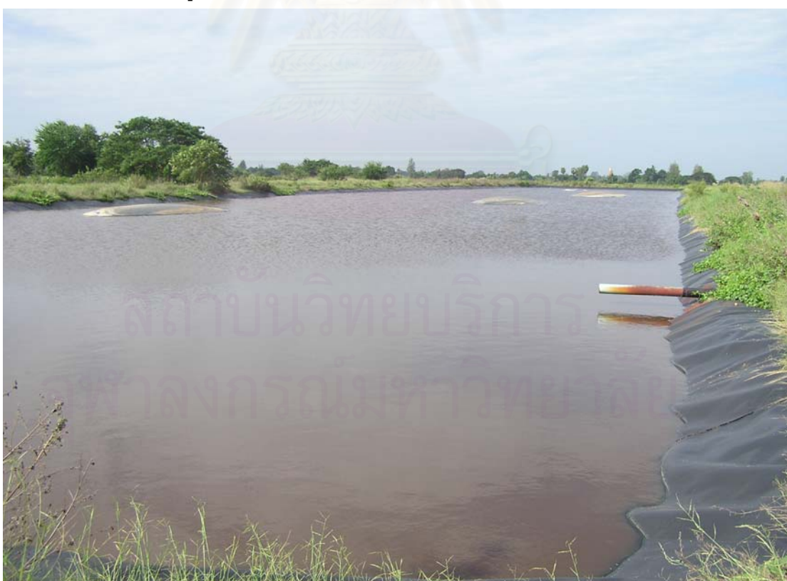
รูปที่ ง.62 สภาพบ่อน้ำบาดาน้ำชะมูลฝอยของทม.อ่างทอง
