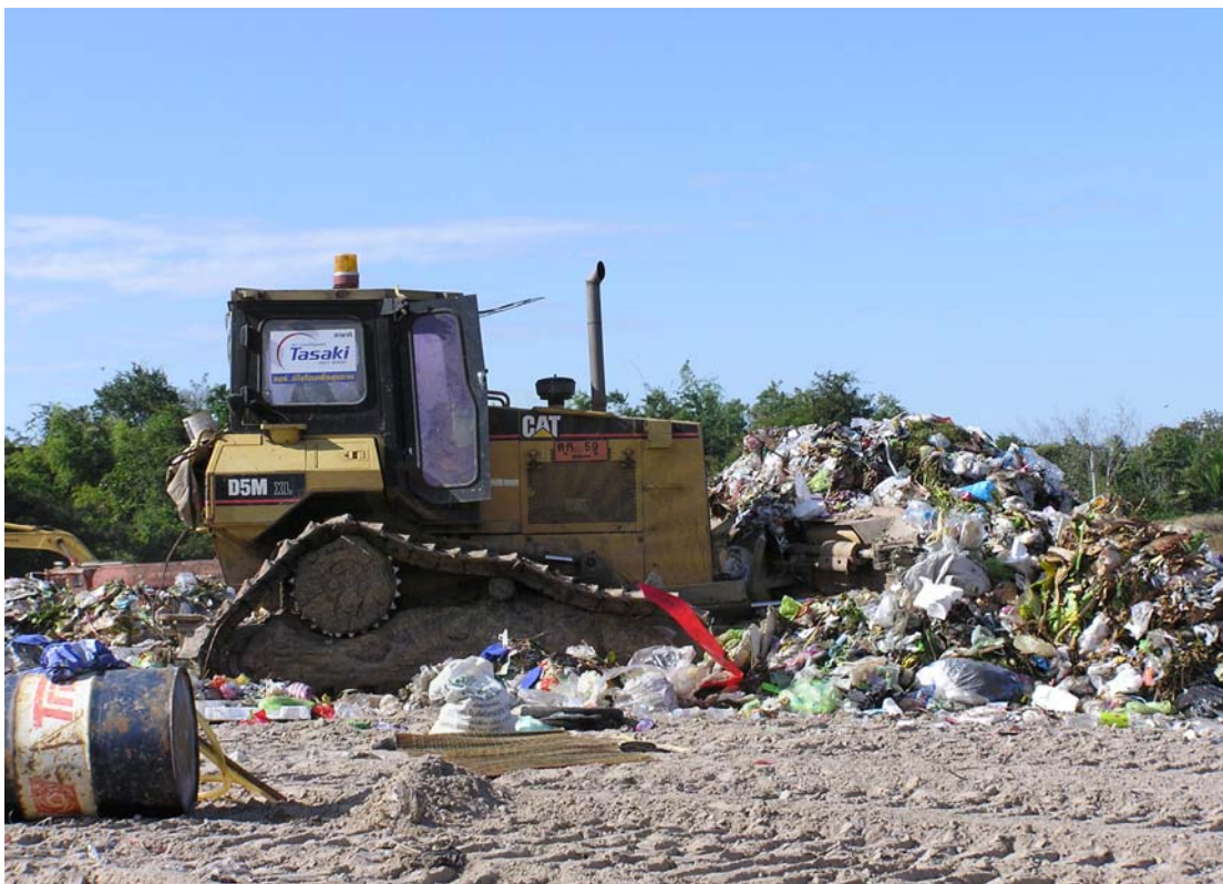
รูปที่ ง.47 การบดอัดขยะมูลฝอยของทม.สกลนคร
