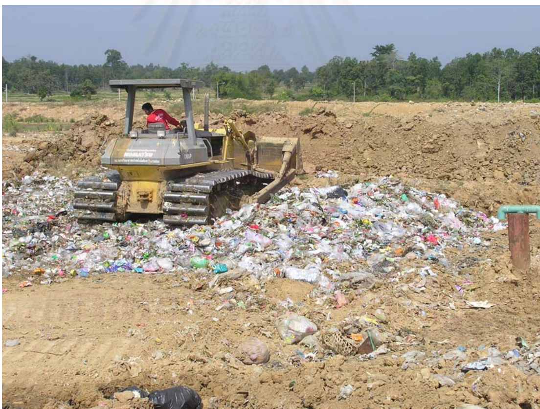
รูปที่ ง.32 การบดอัดขยะมูลฝอยในเซลล์ฝังกลบของทม.บุรีรัมย์
