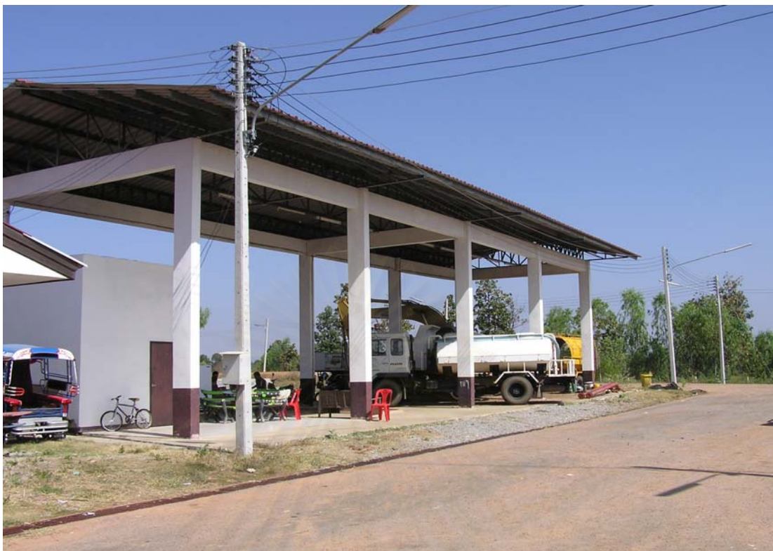
รูปที่ 4 สภาพอาคารจอดเครื่องจักรของโครงการทด.เชียงใหม่
