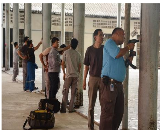
ภาพที่ 10 ปรับปรุงระบบไฟฟ้าภายในอาคาร และเปลี่ยนหลอดไฟ LED
