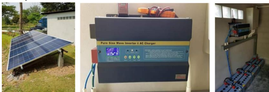
ภาพที่ 6 การติดตั้งระบบผลิตไฟฟ้าสำหรับบิ่มน้ำอัตโนมัติและระบบแสงสว่าง
