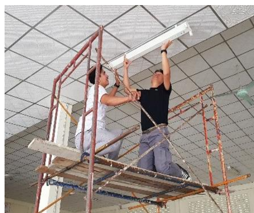
ภาพที่ 10 ปรับปรุงระบบไฟฟ้าภายในอาคาร และเปลี่ยนหลอดไฟ LED
