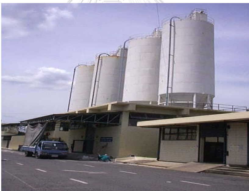
ภาพที่ 33 สถานีเก็บปูนขาวเพื่อส่งจ่าย ที่มา: วิบูลย์ ประทุมรัตน์
