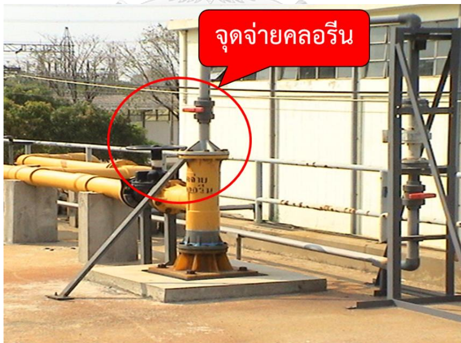
ภาพที่ 49 จุดจ่ายคลอรีนที่ถังเก็บน้ำใส ที่มา: วิบูลย์ ประทุมรัตน์
