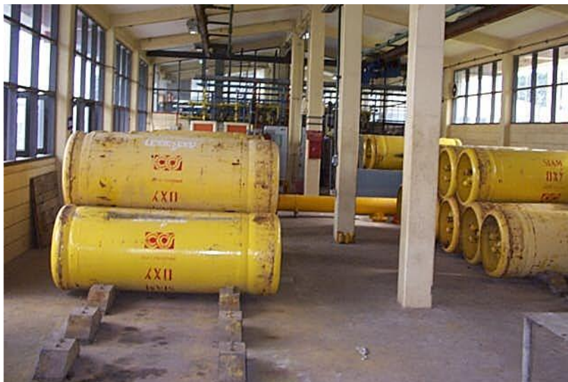
ภาพที่ 32 ถังคลอรีนขนาดความจุ 1 ตัน ที่มา: ทักษิณ กุลานันท์
