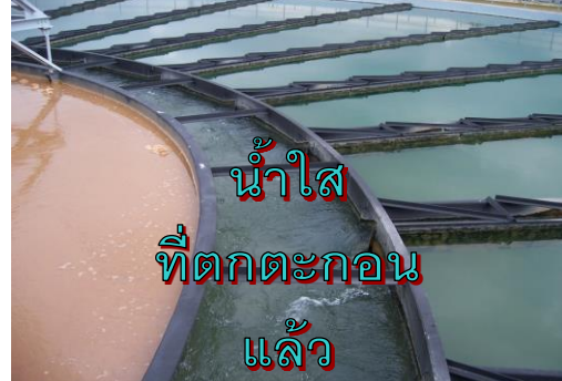
ภาพที่ 39 ภาพแสดงกระบวนการในถังตกตะกอน
