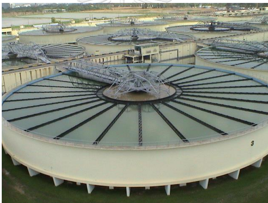
ภาพที่ 34 ถังตกตะกอน (Clarifier Tank)
