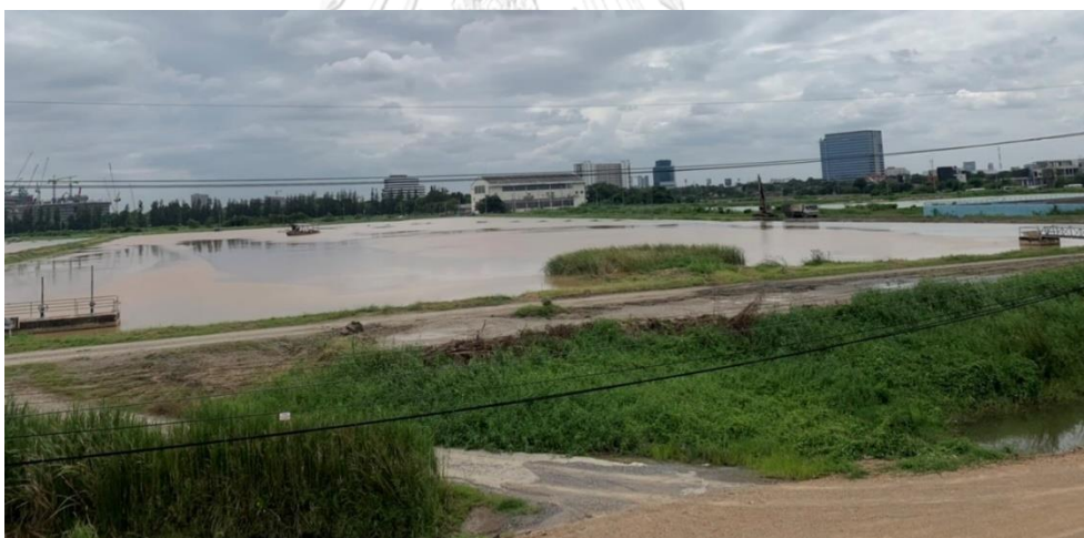
ภาพที่ 47 ลานตากตะกอน (Drying Yard)
