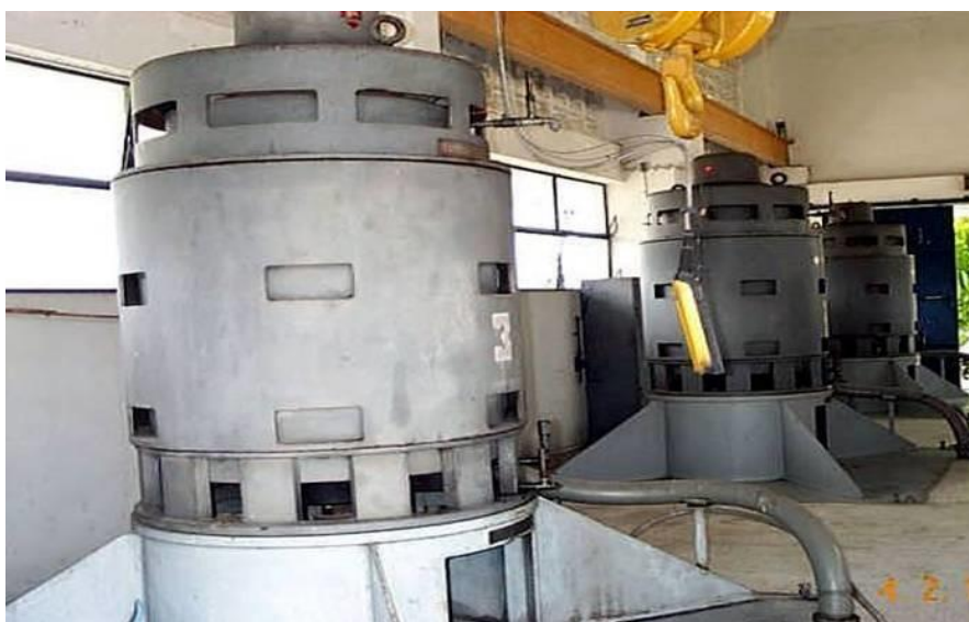
ภาพที่ 13 เครื่องสูบน้ำชนิด Vertical Axial Flow
