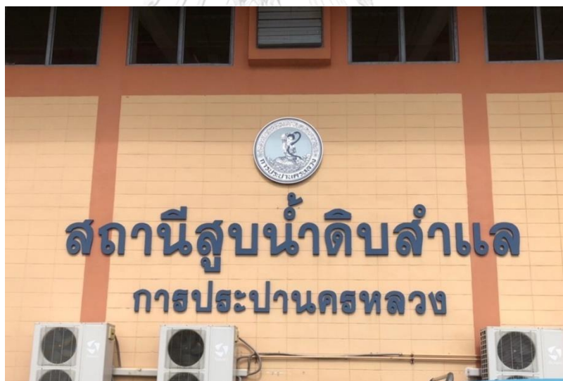
ภาพที่ 6 สถานีสูบน้ำดิบสำแล
