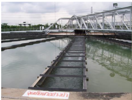
ภาพที่ 39 ภาพแสดงกระบวนการในถังตกตะกอน
