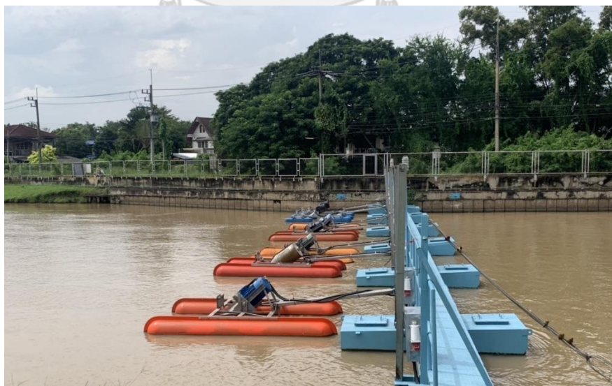
ภาพที่ 15 เครื่องเติมอากาศช่วยเพิ่มปริมาณออกซิเจนละลายน้ำ
