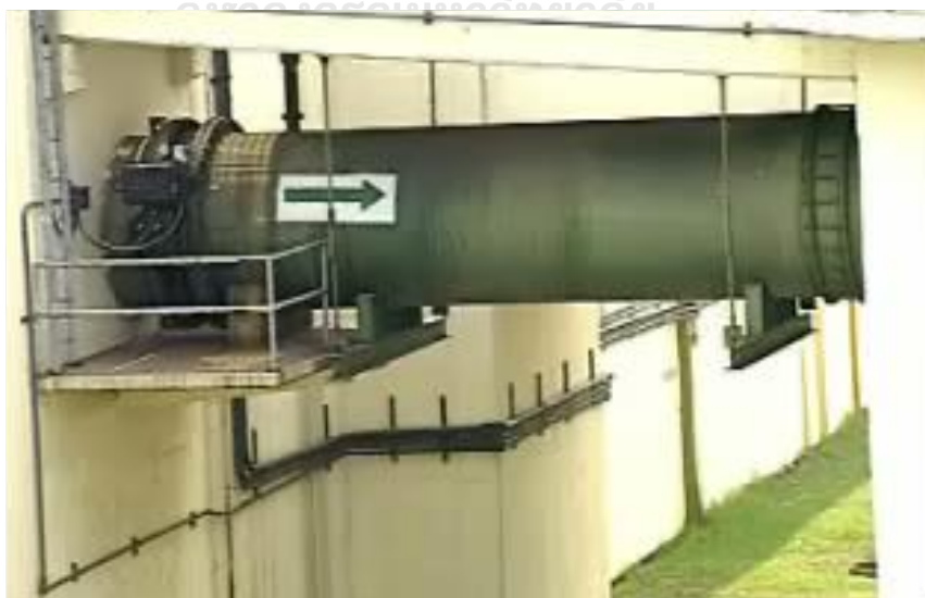
ภาพที่ 36 ส่วนทำปฏิกิริยาผ่านการกวนเร็ว ที่มา: วิบูลย์ ประทุมรัตน์
