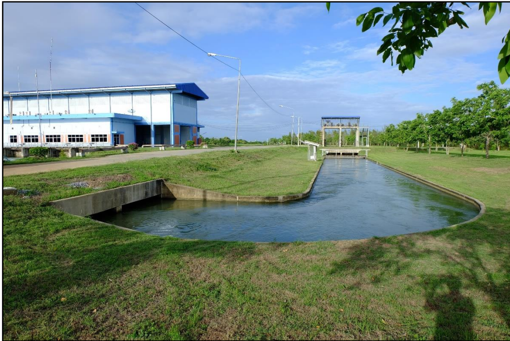
ภาพที่ 24 แสดงการไหลของน้ำผ่านแรงโน้มถ่วงของโลก แบบคลองอ้อม (Banglen Bypass) จากบริเวณสถานีสูบน้ำดิบบางเลนถึงโรงงานผลิตน้ำมหาสวัสดิ์ ที่มา: จักรพันธ์ บุญสุข
