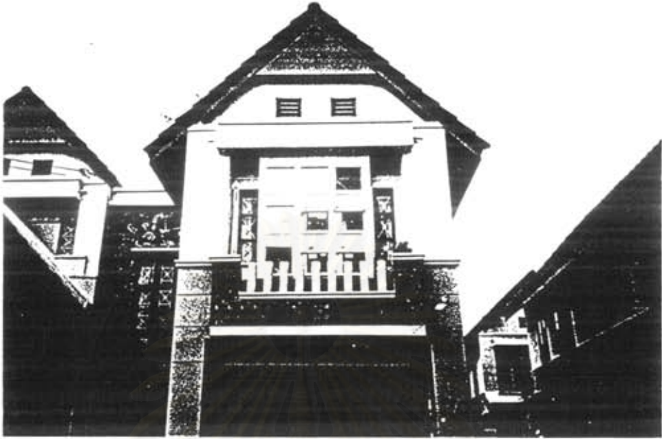
ภาพที่ 10 แสดงลักษณะทางกายภาพภายนอกของอาคารทดลอง ในช่วงเวลากลางวัน
