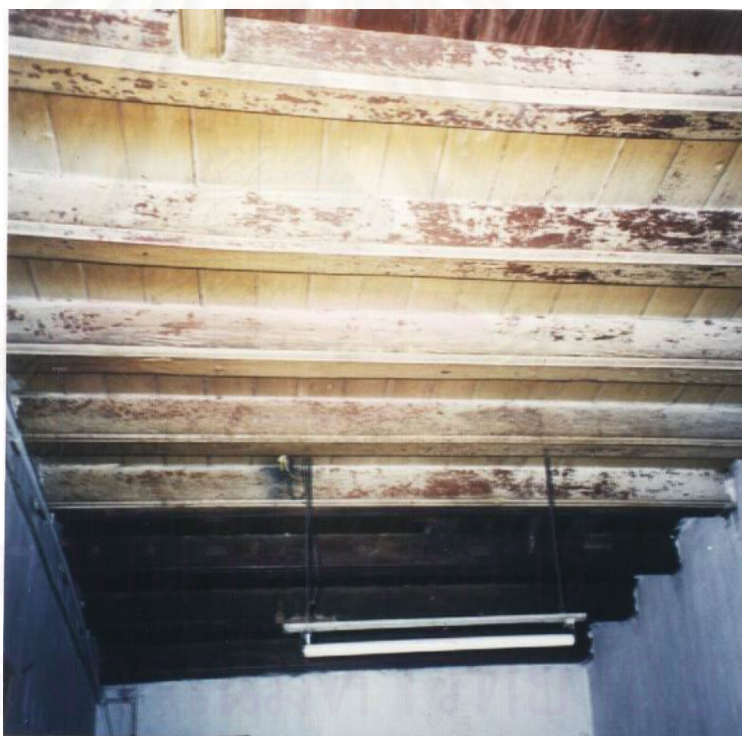
ภาพที่ 88 แสดงพื้นไม้ชั้นบนและการรับน้ำหนักโดยคานไม้
