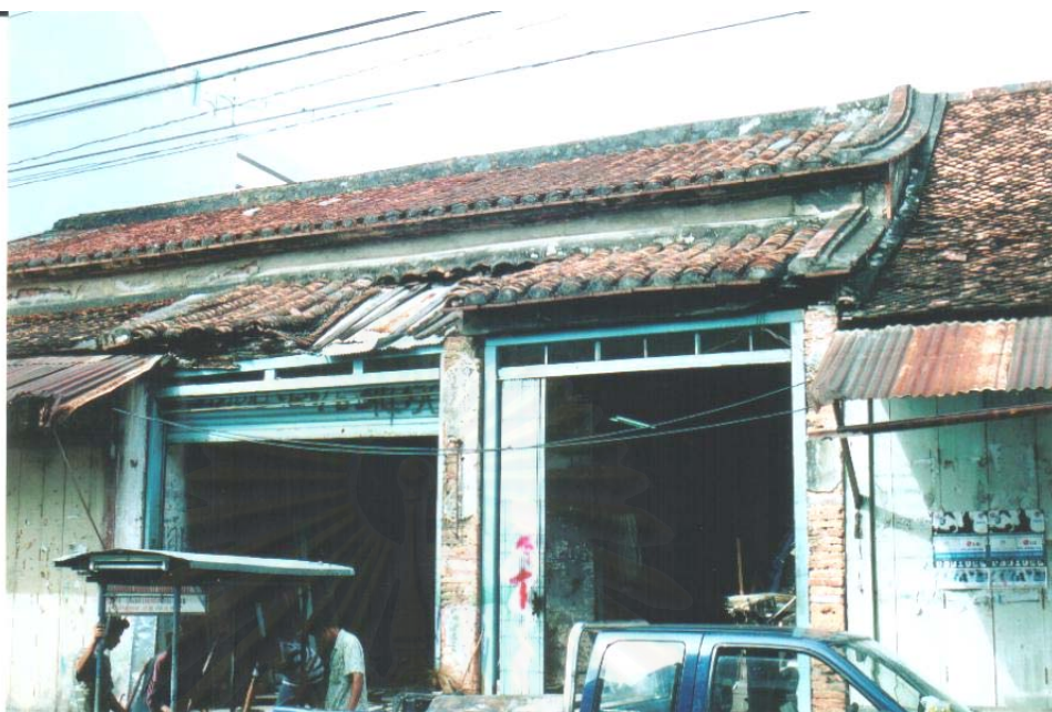
ภาพที่ 72 สภาพห้องแถวบริเวณถนนนครในที่มีการดัดแปลงเพื่อประกอบธุรกิจโรงเชื่อมโลหะ ที่มา: การสำรวจโดยผู้ศึกษา กรกฎาคม 2546
