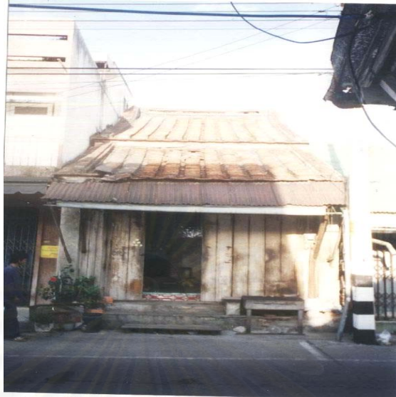
ภาพที่ 117 ด้านหน้าอาคารชั้นเดียว เลขที่ 168 ถนนนครใน
