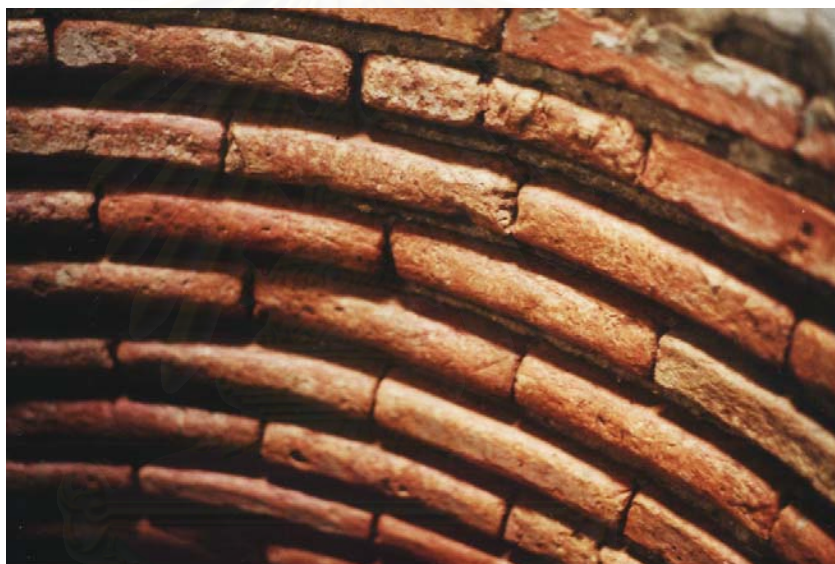
ภาพที่ 125 การใช้อิฐเป็นวัสดุก่อสร้าง นำมาก่อสลับนวตั่งและนวนอนเพื่อเป็นเสาหรือผนังรับน้ำหนัก
