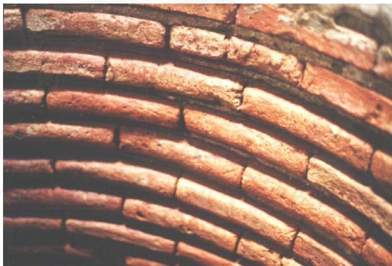
ภาพที่ 83 อิฐหน้าวงรูปโค้งใช้ก่อผนังภายในอาคารแบบตะวันตก ถนนนางงาม
