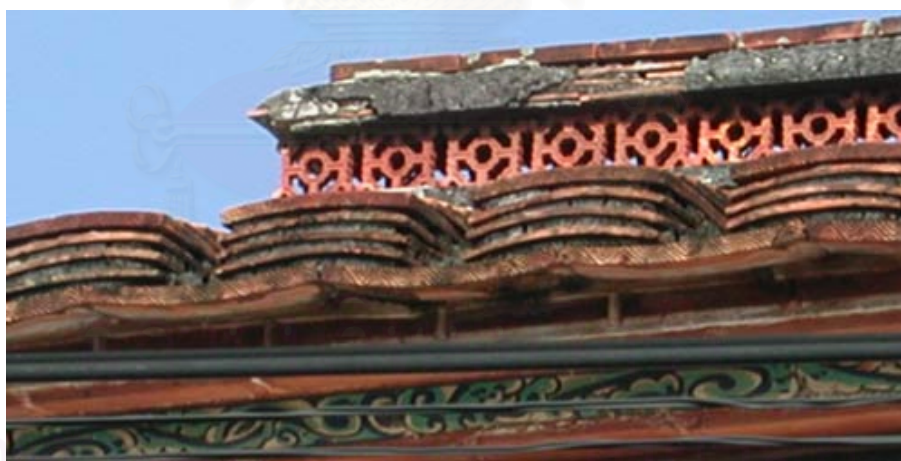
ภาพที่ 96 รายละเอียดลวดลายที่ใช้ตกแต่งบริเวณสันหลังคา
