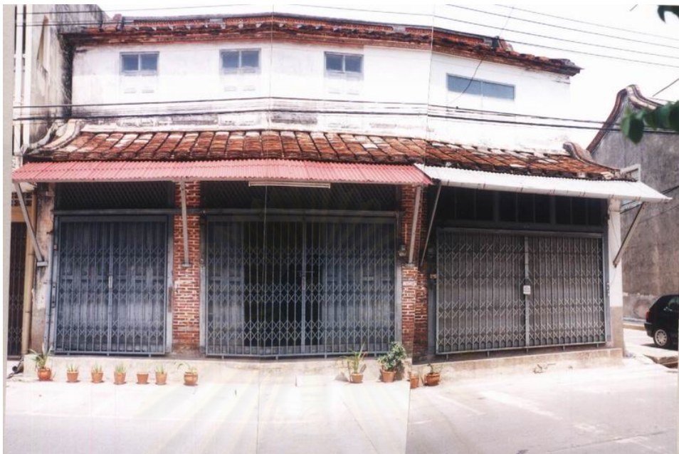
ภาพที่ 40 อาคารเลขที่ 94 ถนนนครใน
