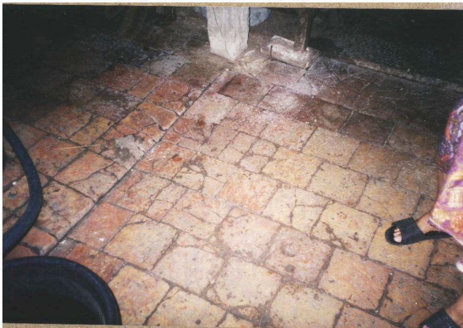
ภาพที่ 27 พื้นภายในอาคารทำจากกระเบื้องหน้าวัว
