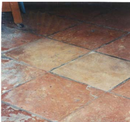
ภาพที่ 86 แสดงพื้นภายในอาคารห้องแถวเมืองสงขลาที่ปูด้วยกระเบื้องหน้าวัวรูปสี่เหลี่ยมจัตุรัส
