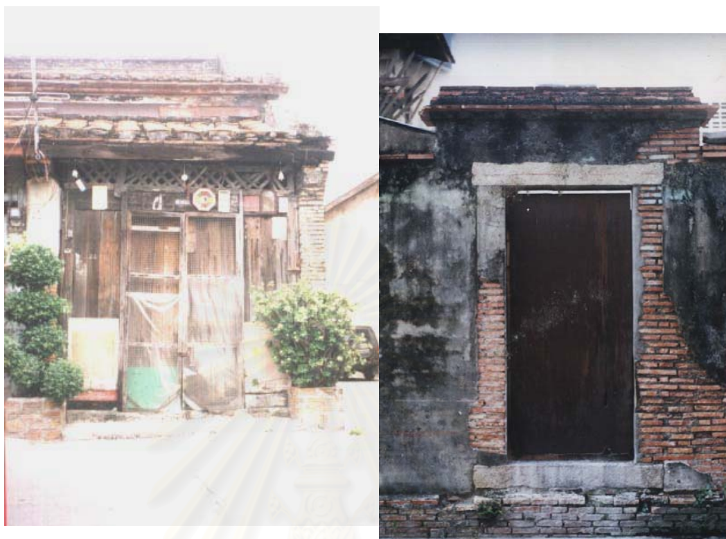
ภาพที่ 103 ประตูด้านหน้าและประตูด้านข้างอาคาร
