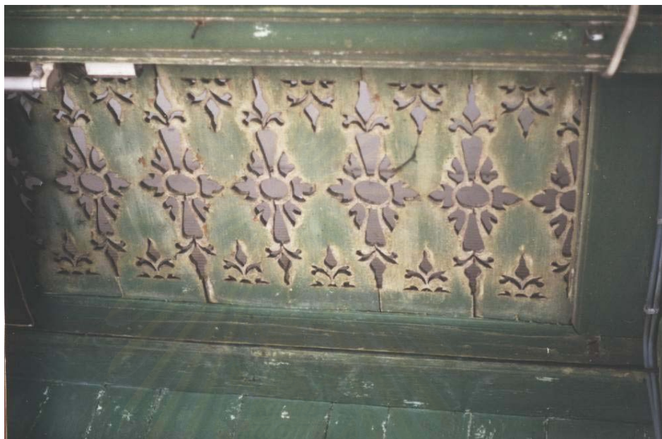
ภาพที่ 110 ช่องลมไม้ฉลุในอาคารรูปแบบตะวันตก
